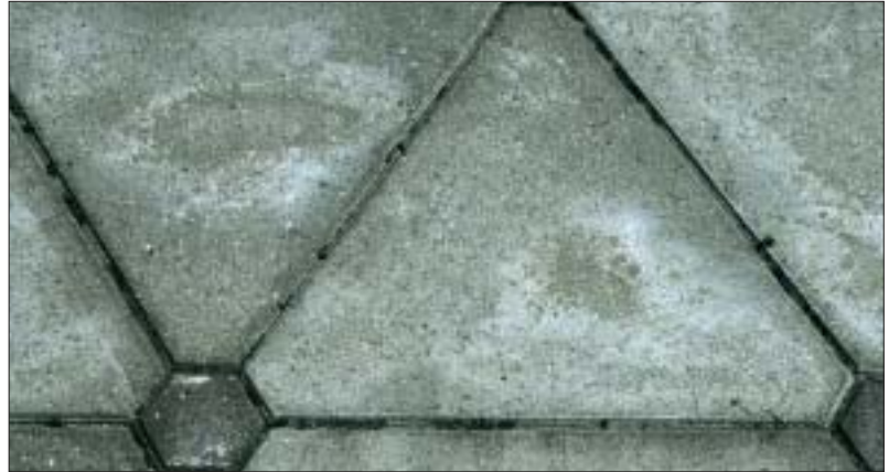
Figur 4.7. Kalkudblomstringer på et år gamle fliser, der ikke har været udsat for slid. Kalkudblomstringer skader på ingen måde betonen.
