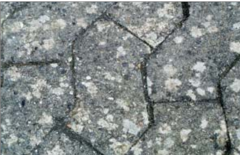
Figur 4.6. De hvide/grålige lavbevoksninger er sværere at fjerne end de grønne alger, men der findes midler der klarer dette. Her et kraftigt angreb på 25 år gamle belægningssten.
