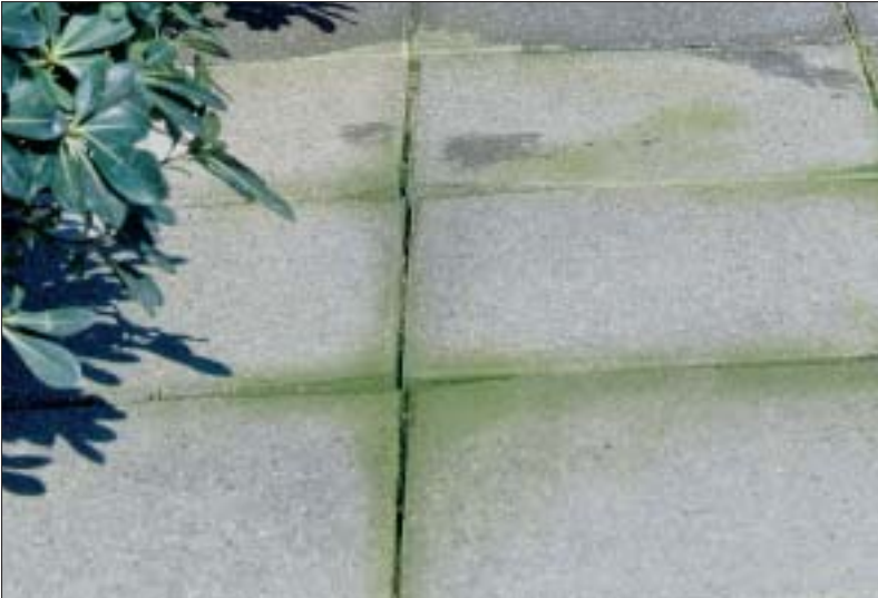
Figur 4.5. Den grønne alge er meget almindelig, og er rimelig let at fjerne. Algen ses på mange forskellige overflader, mure, biler, plankeværk, fliser, træer mv.
